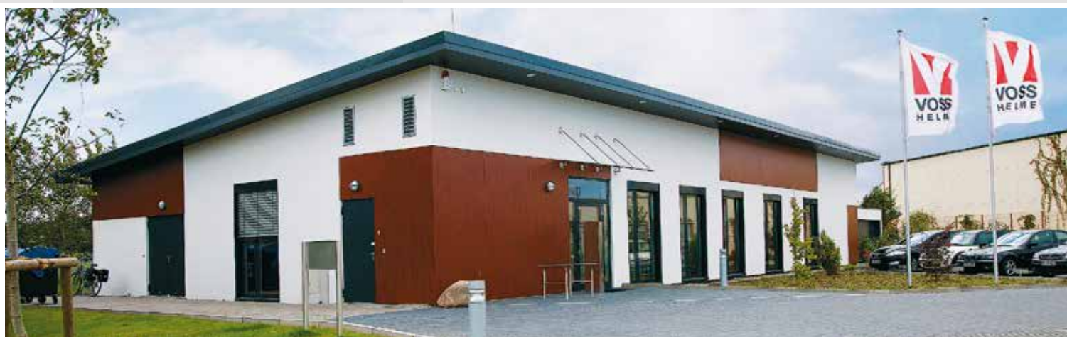
Nuestro edificio de administración – una moderna casa solar autónoma
